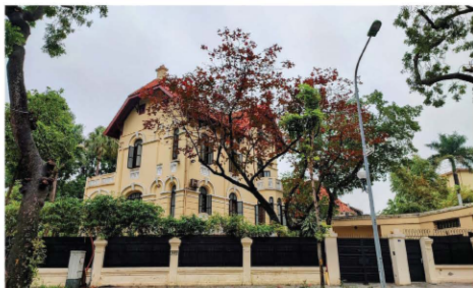
Biệt thự ở phố Điện Biên Phủ, phường Ba Đình, Hà Nội, một công trình di sản kiến trúc được trùng tu thích ứng trong bối cảnh mới (3)
